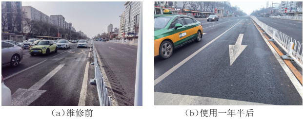
图 6 高黏高弹聚合物改性沥青混合料试验段前后对比
