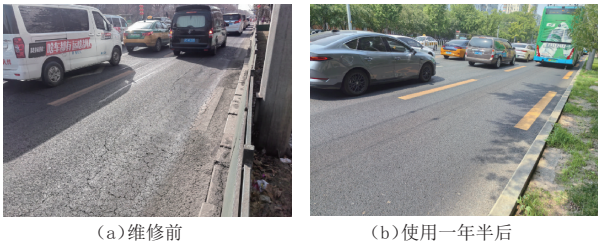
图 7 高模量沥青混合料试验段前后对比
