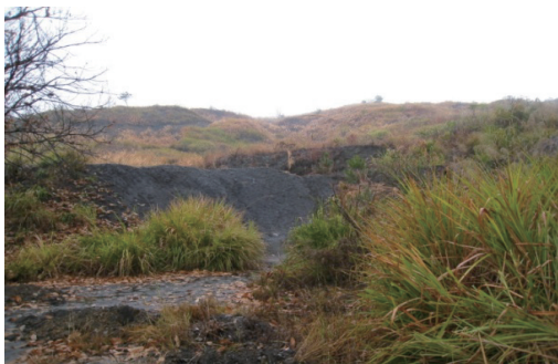
图8 路段煤系土边坡现场
